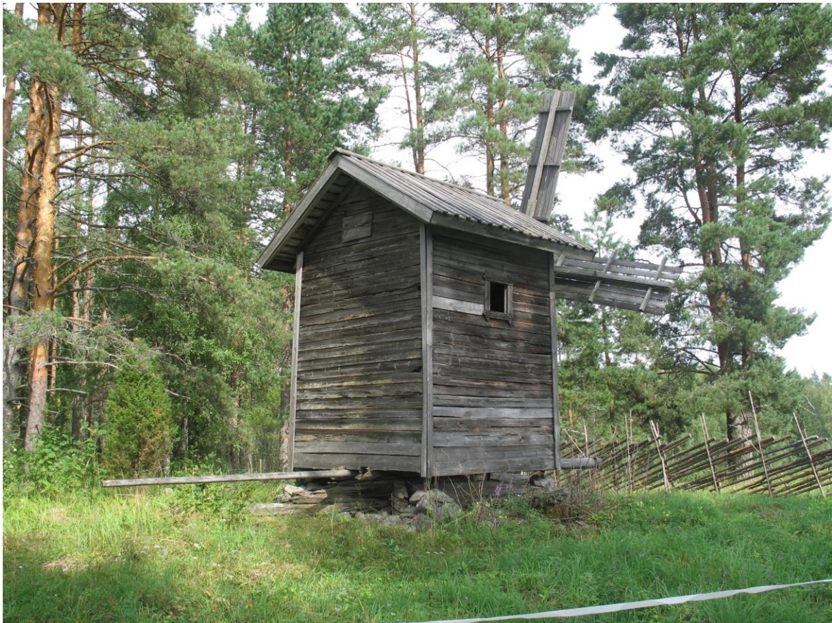
Kuva 4. Säärasitukselle altistumisen seurauksena harmaantunut tuulimyllyn puupinta.
